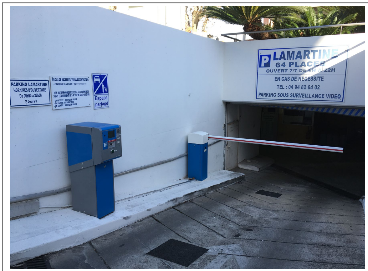
Observation 1 : Installation d'un dispositif sonore et visuel avec information de prise en compte de l'appel
