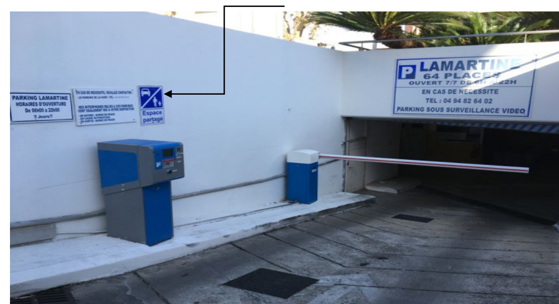
Observation 2: Pose d'une bande de guidage contrastée et tactile vers la sortie ascenseur : Installation d'un panneau à l'entrée indiquant qu'il s'agit d'un espace partagé entre les piétons et les véhicules
