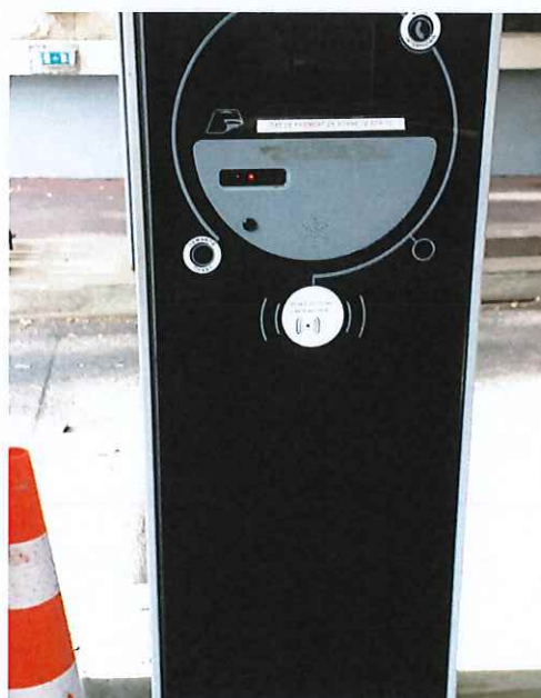
Observations 2: Installation d'un dispositif sonore et visuel de prise en compte de l'appel en bornes d'entrée/sortie
