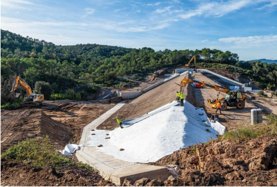
Les travaux du barrage de l'Aspé se termineront en mars 2025
