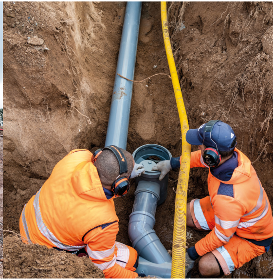
Modernisation des réseaux de distribution destinée à réduire les déperditions en eau potable engendrées par les fuites et la vétusté des installations.
